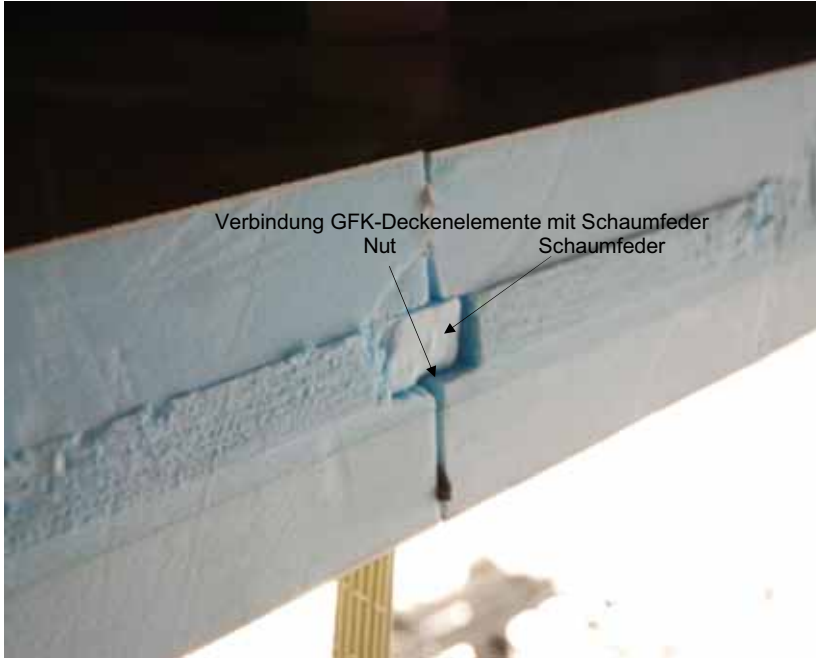
Verbindung Decke Nut und Feder
